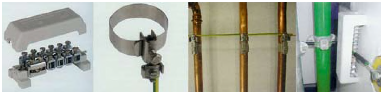
6 pav. Potencialų suvienodinimo laidininkų prijungimo pavyzdžiai
